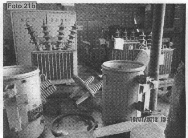
Fotografías N° 21a y 21b – Transformadores desmontados en proceso de mantenimiento en los talleres de la empresa TECSUR S.A., ubicado en Av. Pedro Miotta Cuadra, distrito de San Juan de Miraflores.
