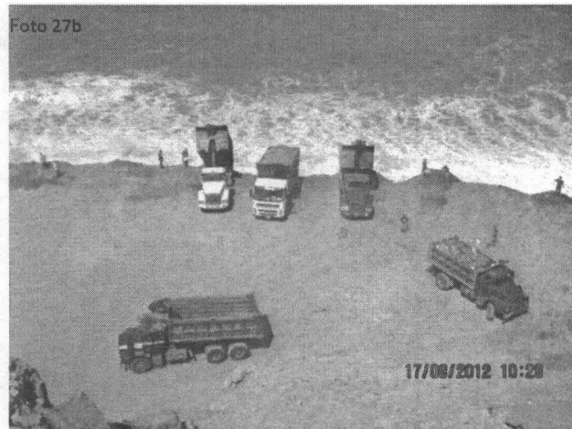
Fotografías N° 27a y 27b. Zona de descarga de residuos de construcción y escombros en la orilla de playa para ganar terreno al mar, nótese el grado de mezcla y dispersión de los residuos con el agua de mar producto de la fuerza de las olas. Coordenadas UTM WGS 84 (18L 0271517E 8663128N)
