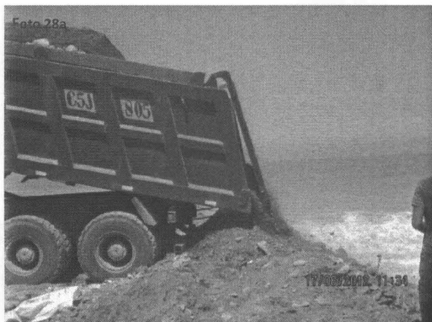
Fotografías N° 28a y 28b. Zona de descarga de residuos de construcción y escombros en la orilla de playa para ganar terreno al mar; nótese el grado de mezcla Y dispersión de los residuos con el agua de mar producto de la fuerza de las olas. Coordenadas UTM WGS 84 (18L 0271511E 8663046N)
