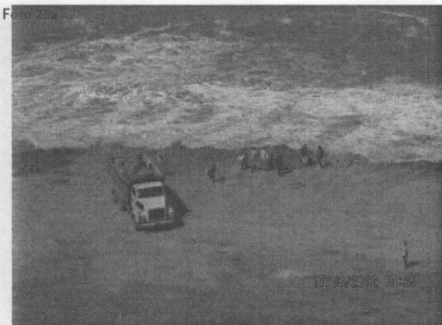
Fotografías N° 25a y 25b. Zona de descarga de residuos de construcción y escombros en la orilla de playa para ganar terreno al mar, nótese el grado de mezcla y dispersión de los residuos con el agua de mar producto de la fuerza de las olas. Coordenadas UTM WGS 84 (18L 0271517E 8663128N)
