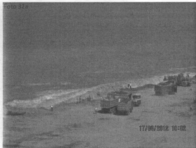
Fotografías N° 32a y 32b. Zona de descarga de residuos de construcción y escombros en la orilla de playa para ganar terreno al mar, visto desde la parte alta del acanilado, nótese el grado de mezcla y dispersión de los residuos con el agua de mar producto de la fuerza de las olas. Coordenadas UTM WGS 84 (18L 0271511E 8663046N)
