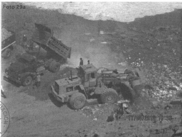
Fotografías N° 29a y 29b. Zona de descarga de residuos de construcción y escombros en la orilla de playa para ganar terreno al mar; nótese el grado de mezcla Y dispersión de los residuos con el agua de mar producto de la fuerza de las olas. Coordenadas UTM WGS 84 (18L 0271517E 8663128N)
