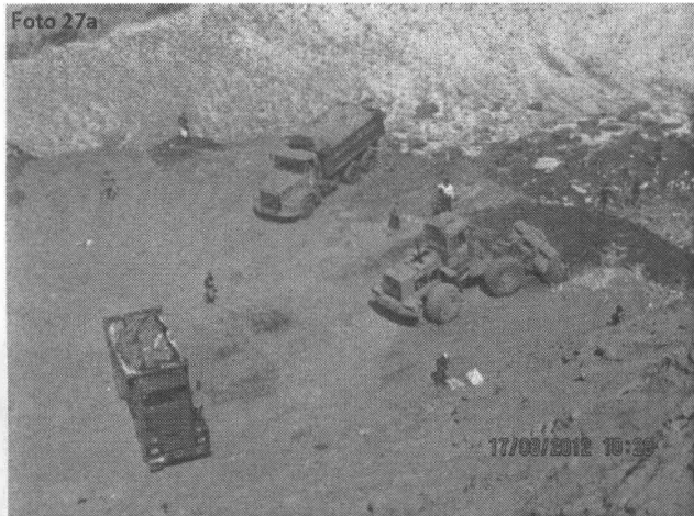
Fotografías N° 27a y 27b. Zona de descarga de residuos de construcción y escombros en la orilla de playa para ganar terreno al mar, nótese el grado de mezcla y dispersión de los residuos con el agua de mar producto de la fuerza de las olas. Coordenadas UTM WGS 84 (18L 0271517E 8663128N)
