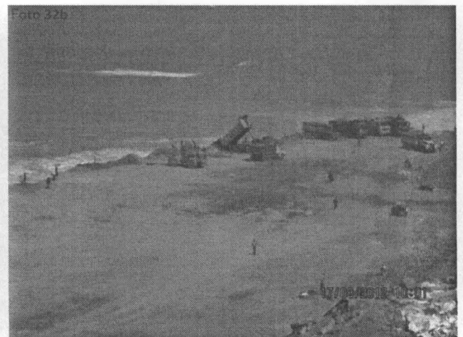
Fotografías N° 32a y 32b. Zona de descarga de residuos de construcción y escombros en la orilla de playa para ganar terreno al mar, visto desde la parte alta del acanilado, nótese el grado de mezcla y dispersión de los residuos con el agua de mar producto de la fuerza de las olas. Coordenadas UTM WGS 84 (18L 0271511E 8663046N)
