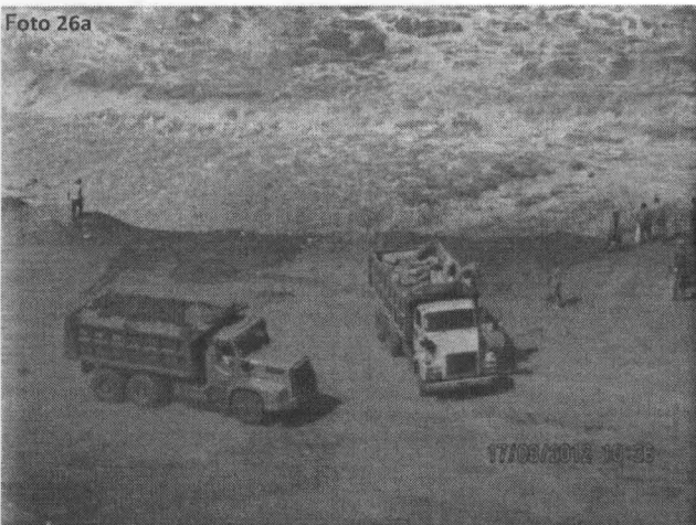
Fotografías N° 26a y 26b. Zona de descarga de residuos de construcción y escombros en la orilla de playa para ganar terreno al mar; nótese el grado de mezcla Y dispersión de los residuos con el agua de mar producto de la fuerza de las olas. Coordenadas UTM WGS 84 (18L 0271511E 8663046N)
