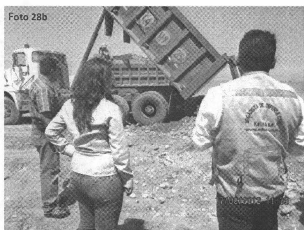
Fotografías N° 28a y 28b. Zona de descarga de residuos de construcción y escombros en la orilla de playa para ganar terreno al mar; nótese el grado de mezcla Y dispersión de los residuos con el agua de mar producto de la fuerza de las olas. Coordenadas UTM WGS 84 (18L 0271511E 8663046N)
