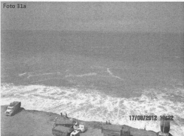
Fotografías N° 31a y 31b. Zona de descarga de residuos de construcción y escombros en la orilla de playa para ganar terreno al mar, visto desde la parte alta del acanilado, nótese el grado de mezcla y dispersión de los residuos con el agua de mar producto de la fuerza de las olas. Coordenadas UTM WGS 84 (18L 0271517E 8663128N)
