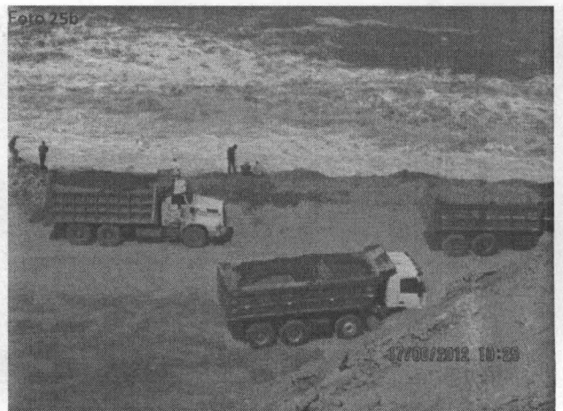
Fotografías N° 25a y 25b. Zona de descarga de residuos de construcción y escombros en la orilla de playa para ganar terreno al mar, nótese el grado de mezcla y dispersión de los residuos con el agua de mar producto de la fuerza de las olas. Coordenadas UTM WGS 84 (18L 0271517E 8663128N)
