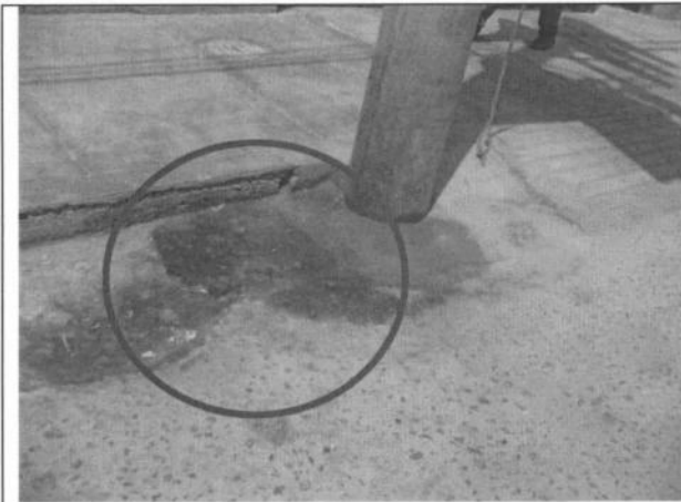
Vista 13 SE 2241 con huellas de aceite en vereda. Chiclayo
