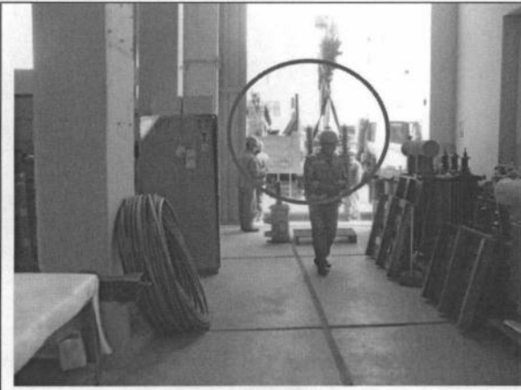
Vista 3 Personal trasladando equipos.
