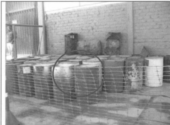
Vista 3 Cilindros con aceite dieléctrico sin identificación de PCBs.
