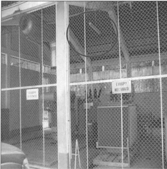
Vista 1 Almacén cercado y techado con piso de concreto.
