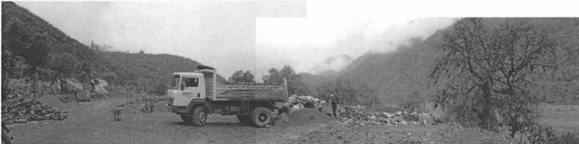
Foto 9: Vista de la maquinaria usada en el sitio de disposición final, se aprovecha para la recolección de los residuos y para el acarreo de material de cobertura
