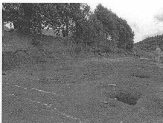
Foto 14: Trabajos para la colección de lixiviados
