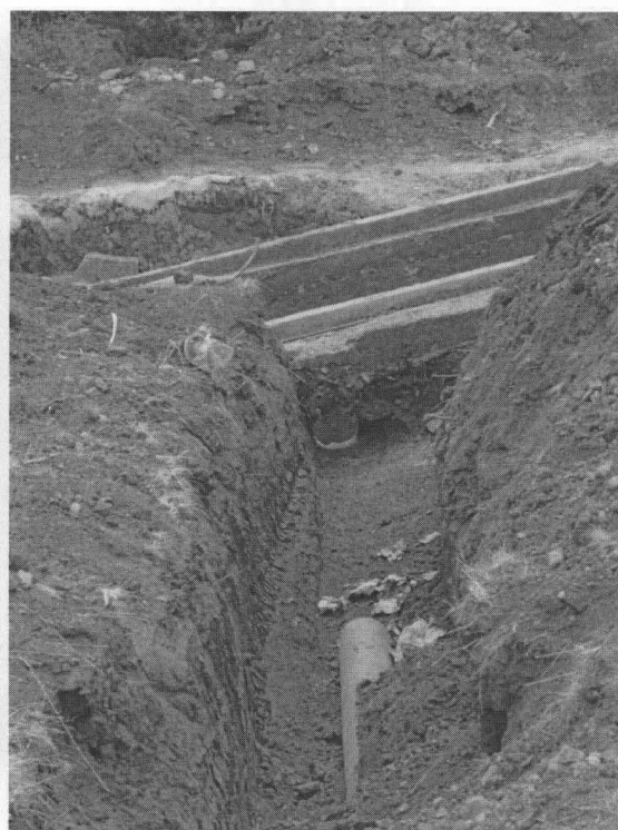
Foto 16: Sistema de captación de lixiviados sobre terreno sin impermeabilizar
