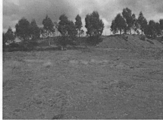
Foto 8: Otra vista del área donde la autoridad manifiesta existe residuos coberturados y no se aprecia ningún sistema de control.
