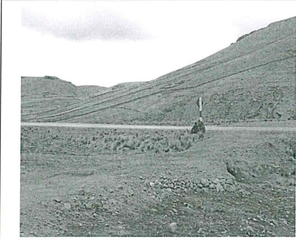
Fotografía 1. Km 250 + 900 tramo Mar de Cruz – Desaguadero de la carretera Binacional Perú - Bolivia. Poblado Huancallani – Chucuito – Puno.
