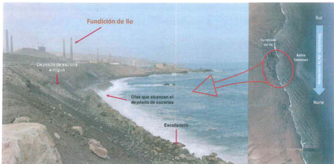
Figura 11-39. Esquema que muestra la acción de las olas sobre el depósito de escorias antiguo aledaño a la Fundición de Ilo de Southern Peru Copper Corporation (SPCC)
