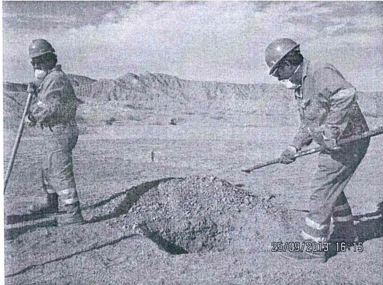
Fotografía N° 3. Ubicación del punto de monitoreo S-2 aledaño a pozo ATA EA 9603, no cercado.
