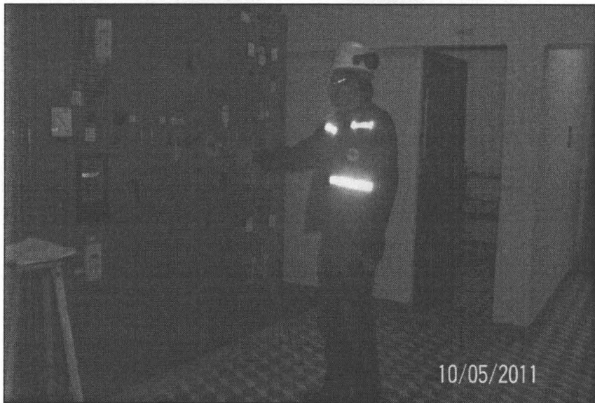
Fotografía N° 6: Medición de niveles de iluminación en la zona de tableros, correspondiente a la SET Antauta.
