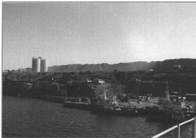
Fotografía N° 10 Zona de Operaciones de los Silos
