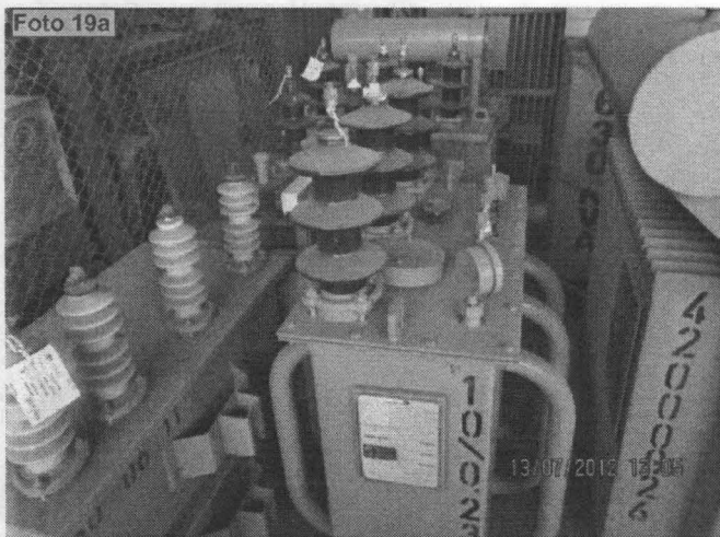
Fotografías N° 19a y 19b – Transformadores operativos ubicados en el almacén de la empresa LUZ del Sur S.A.A. en Av. Pedro Miotta Cuadra 4 del distrito de San Juan de Miraflores. Nótese las etiquetas rojas del análisis de PCBs
