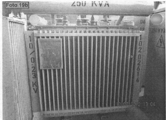
Fotografías N° 19a y 19b – Transformadores operativos ubicados en el almacén de la empresa LUZ del Sur S.A.A. en Av. Pedro Miotta Cuadra 4 del distrito de San Juan de Miraflores. Nótese las etiquetas rojas del análisis de PCBs
