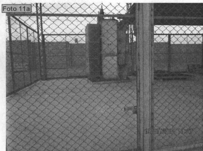
Fotografías N° 11a y 11b – Transformador contaminado con PCBs de 30 KV y de gran tamaño y que sobrepasa la altura del techo por lo que ha sido dispuesto en la parte posterior sin techo del almacén.
