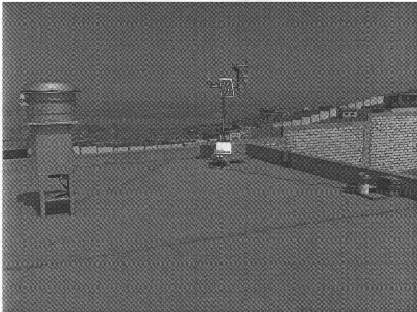
Fotografía N° 01.- Estación meteorológica y muestreador de partículas – Puesto de Salud "San Benito".
