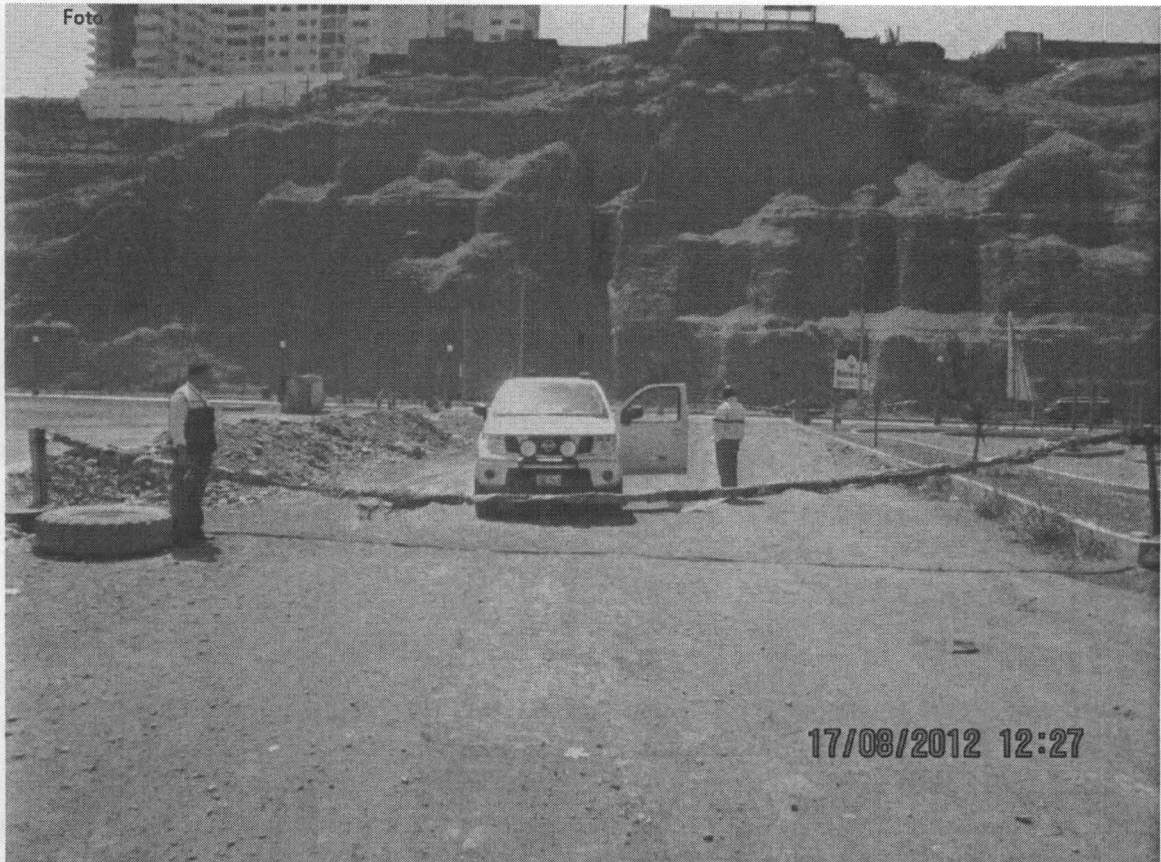
Fotografías N° 4. Primer ingreso a la zona central de la playa Marbella en el distrito de Magdalena del Mar. Evidencias de tranquera con candado para evitar el ingreso de vehículos pesados con residuos de construcción. Coordenadas UTM WGS 84 (18L 0275257E 8661085N)
