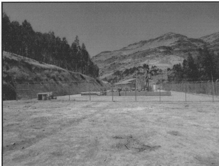
Foto N° 03: Estación de válvulas VS1
