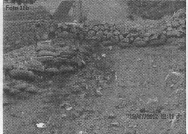
Fotografías N° 18a y 18b. Evidencia de colectores domésticos instalados en los asentamientos humanos con salida directa hacia el cauce del río Lurín, Coordenadas UTM WGS 84 (18L 0293939E 8645030N)
