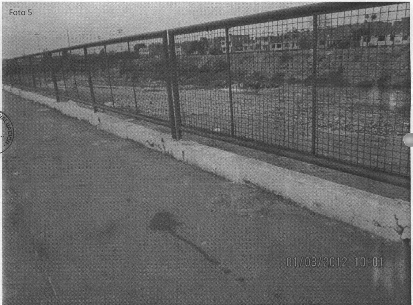
Fotografía N° 5 Vista Panorámica del cauce del río Rímac cercado con una malla metálica en el distrito de Carmen de La Legua – Reynoso intersección con la Jr. José Gálvez. Coordenadas UTM WGS 84 (18L 0272316E 8668337N)
