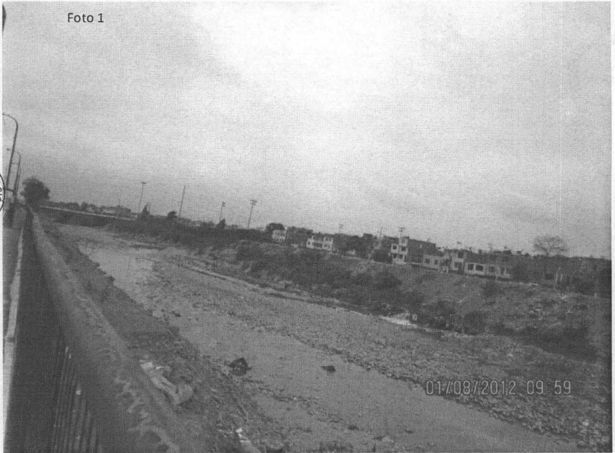
Fotografía N° 01. Vista panorámica del Cerco Perimétrico Metálico colocado a lo largo del cauce del río Rímac en la Jurisdicción del distrito de Carmen de La Legua - Reynoso, empieza a la altura del Puente Elmer Faucett. Coordenadas UTM WGS 84 (18L 0271544E 8668181N)
