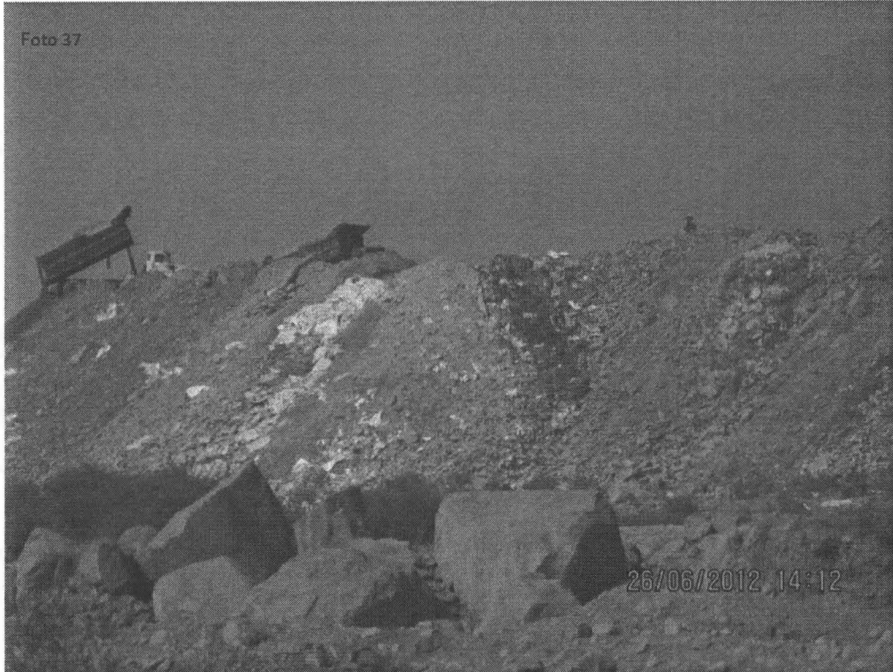
Fotografía N° 37. Zona de avance actual del Botadero Huacoy, donde se disponen grandes cantidades de residuos sólidos de construcción mezclados con residuos industriales, a la altura del cruce del río Chillón con la Av. El Pacayal. Coordenadas UTM WGS 84 (18L 0279512E 8688413N)
