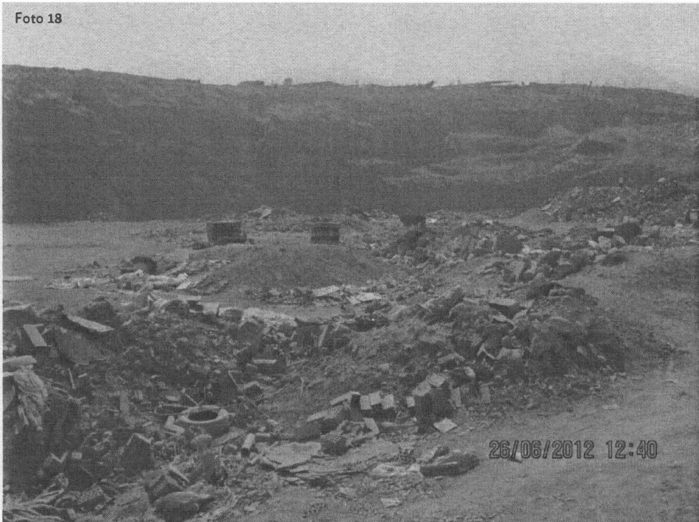
Fotografía N° 18. Vista panorámica de la zona central del Botadero de Vasconia, Nótese la acumulación de residuos mal compactados sobre los cuales existen caminos para el acceso de volquetes y camiones que ingresan a arrojar residuos ha dicho lugar, en el distrito de Carabaylo. Coordenadas UTM WGS 84 (18L 0272468E 8691123N)
