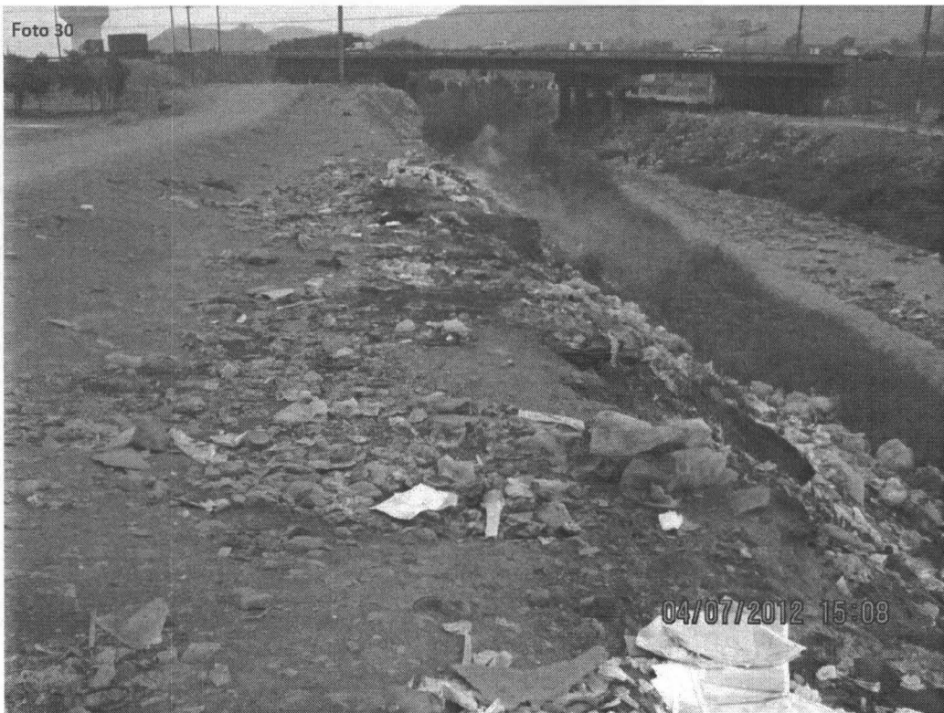
Fotografía N° 30. Vista panorámica del Puente Chillón a la altura del Cruce del Avenida Panamericana con el río Chillón, que evidencia la magnitud del impacto de los residuos sólidos sobre el cauce del río Chillón, en la jurisdicción del distrito de Comas. Coordenadas UTM WGS 84 (18L 0274173E 8681708N)
