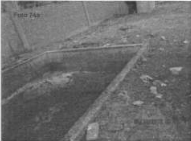
Fotografías N° 74a y 74b Evidencias de total inoperatividad de la poza de sedimentación de bombeo, del Camal Valle Verde, del Distrito de Hualmay. Coordenadas UTM WGS 84 (18L 0215945E 8774247N)
