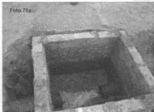
Fotografías N° 71a y 71b Evidencias de inoperatividad de la trampa de sangre N° 2, del Camal Valle Verde, del Distrito de Hualmay. Coordenadas UTM WGS 84 (18L 0215982E 8774220N)
