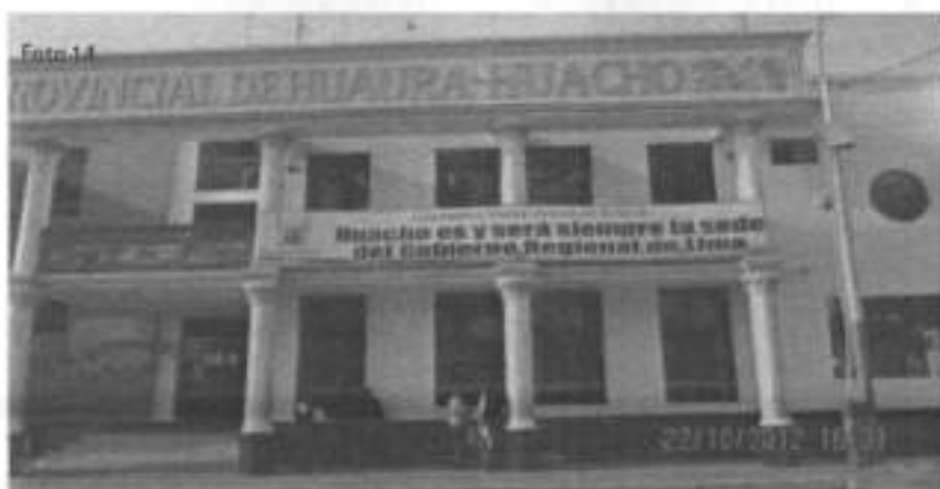
Fotografía N° 14 Vista panorámica del frontis principal actual de la Municipalidad Provincial de Huaura - Huacho.
