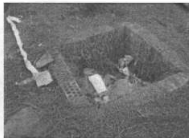
Fotografías N° 73a y 73b Evidencias de total inoperatividad de la trampa de bazofia N° 3, del Camal Valle Verde, del Distrito de Hualmay. Coordenadas UTM WGS 84 (18L 0215956E 8774240N)
