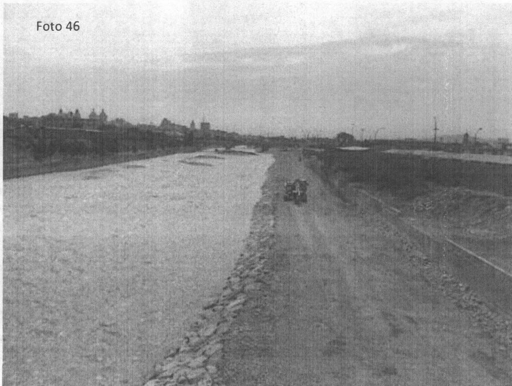
Fotografía N° 46. Vista panorámica del cauce del río Rímac, aguas arriba del Puente Balta, en el punto georeferenciado N° 5, del Cuadro N° 10. Coordenadas UTM WGS 84 (18L 0279762E 8667797N)
