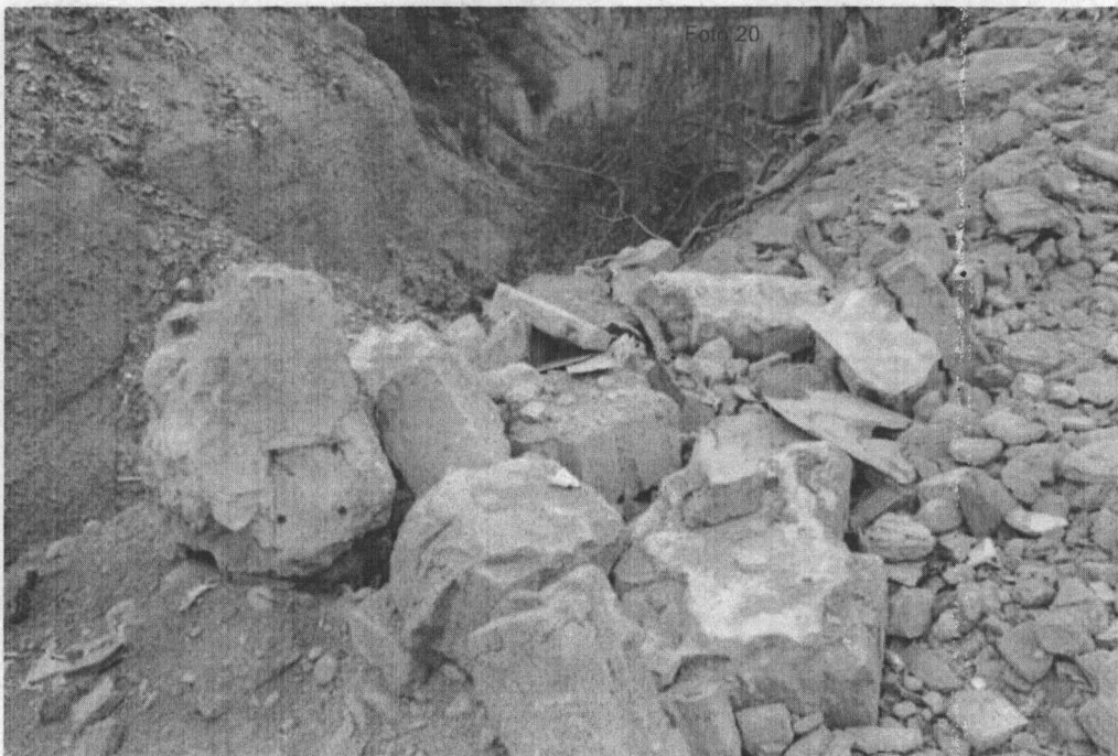
Fotografía N° 20. Evidencia de acumulaciones de residuos de construcción sobre las partes altas del cauce del río Rímac cerca al Puente del Ejército, en el punto georeferenciado N° 1, del Cuadro N° 6. Coordenadas UTM WGS 84 (18L 0277357E 8668299N)
