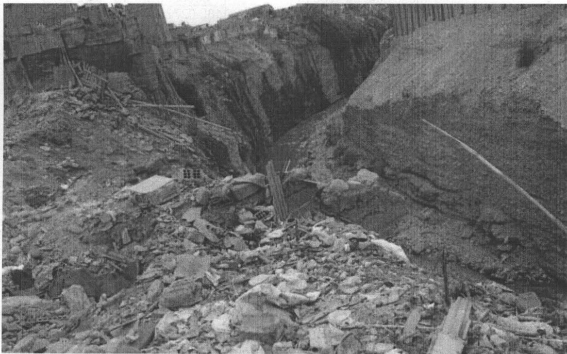
Fotografía N° 19. Evidencia de instalaciones de tuberías de desagüe doméstico, con descarga directa al río Rímac, en el punto georeferenciado N° 2, del Cuadro N° 5. Coordenadas UTM WGS 84 (18L 0277319E 8668315N)
