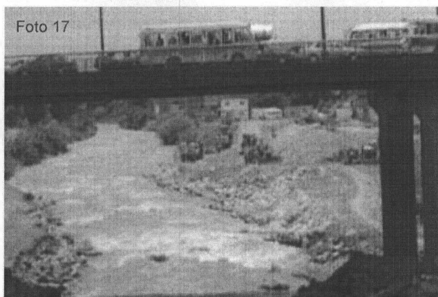
Fotografía N° 17. Vista panorámica del cauce del río Rímac, a la altura del Puente de la Av. Tacna, en el punto georeferenciado N° 1, del Cuadro N° 4. Coordenadas UTM WGS 84 (18L 0278601E 8668067N)
