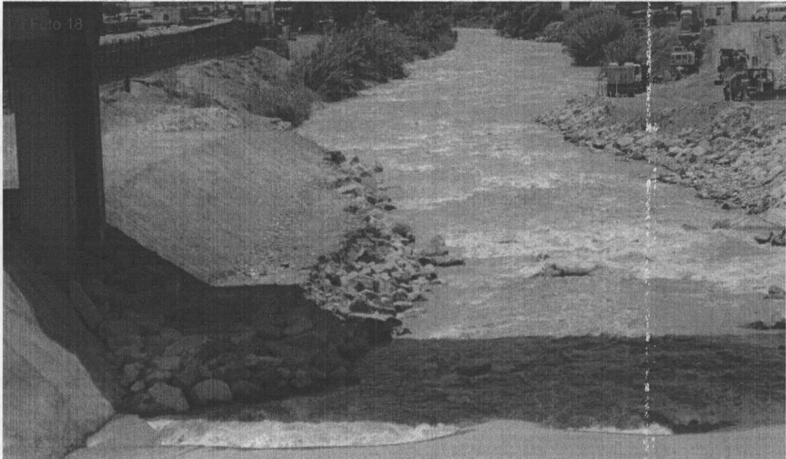
Fotografía N° 18. Vista panorámica del cauce del río Rímac, a la altura del Puente de la Av. Tacna, en el punto georeferenciado N° 1, del Cuadro N° 4. Coordenadas UTM WGS 84 (18L 0278601E 8668067N)
