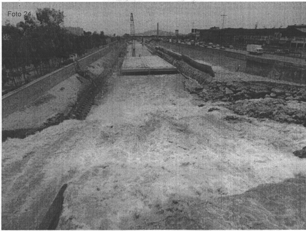
Fotografía N° 24. Vista panorámica del cauce del río Rímac, aguas abajo del Puente Trujillo, en el punto georeferenciado N° 3, del Cuadro N° 4. Coordenadas UTM WGS 84 (18L 0279044E 8667871N)
