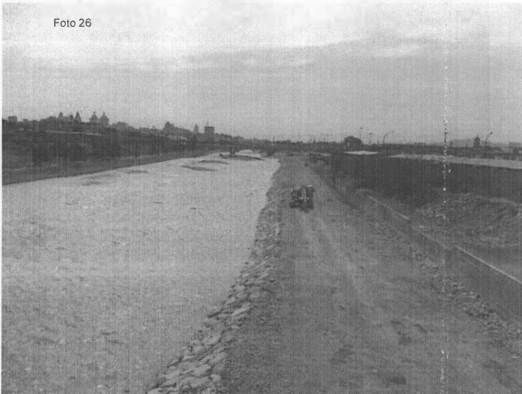
Fotografía N° 26. Vista panorámica del cauce del río Rímac, aguas arriba del Puente Balta, en el punto georeferenciado N° 5, del Cuadro N° 4. Coordenadas UTM WGS 84 (18L 0279755E 8667840N)
