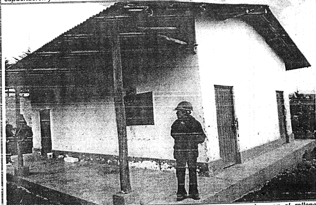
FOTO N° 08: Caseta de guardiania y almacén de herramientas y equipos en el relleno sanitario municipal.
