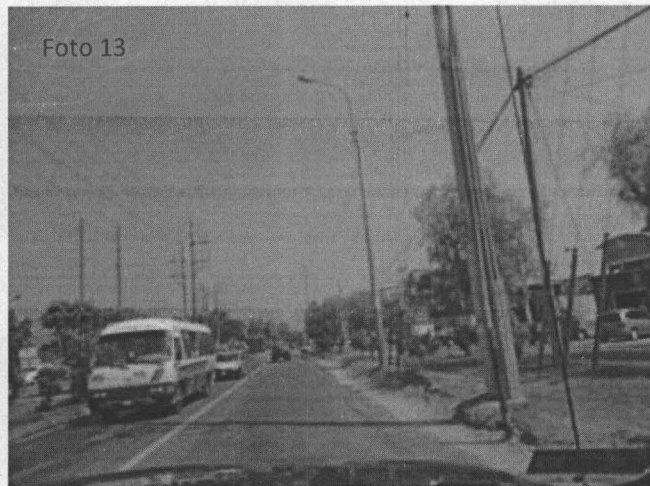
Fotografía N° 13. Vista panorámica de las vías y bermas centrales, en el punto georeferenciado N° 8, del Cuadro N° 2, Coordenadas UTM WGS 84 (18L 0289110E 8663471N)
