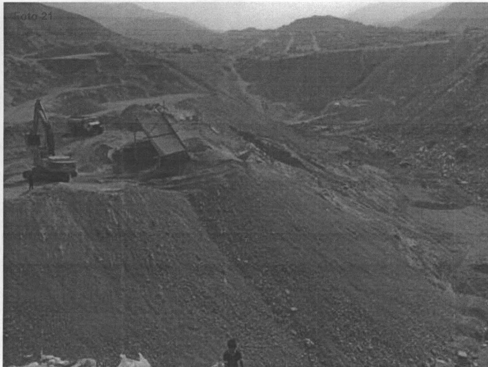
Fotografía N° 21. Evidencia de la explotación de materiales de cantera, en el punto georeferenciado N° 8, del Cuadro N°1. Coordenadas UTM WGS 84 (18L 0297261E 8662872N)
