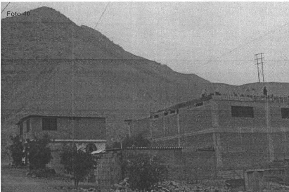
Fotografía N° 40. Evidencias del estado de limpieza de las bermas centrales de la Av. La Molina, a la altura del barrio Magda Portal, en el punto georeferenciado N° 3, del Cuadro N° 4. Coordenadas UTM WGS 84 (18L 0302165E 8660095N)
