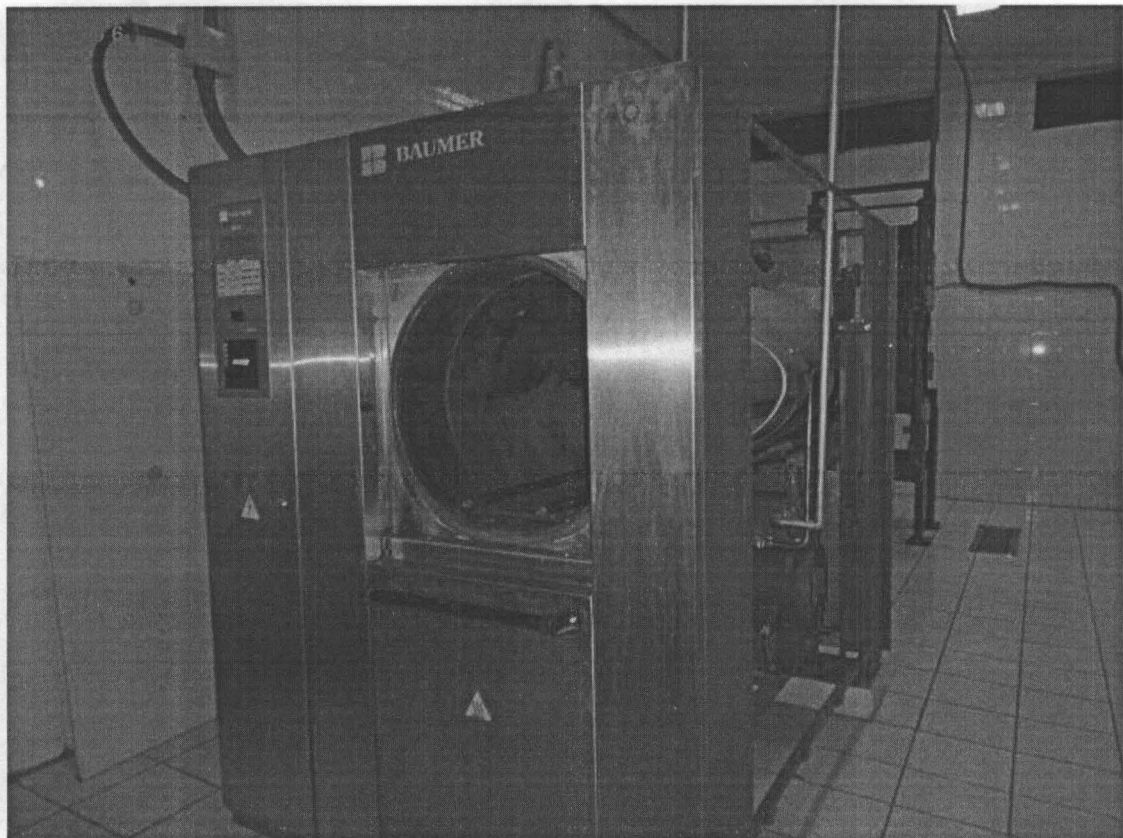
Fotografía N° 6. Evidencia de la operatividad del equipo autoclave para el tratamiento de residuos de establecimientos de salud y servicios médicos de apoyo de la empresa PROMAS. Coordenadas UTM WGS 84 (17L 0713151E 9109699N)
