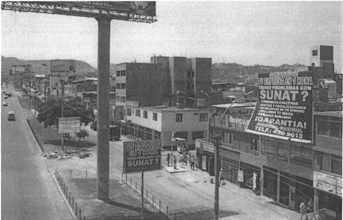
Fotografía N° 36. Vista panorámica de las bermas laterales de la Av. Miguel Iglesias, en el punto georeferenciado N° 6, del Cuadro N° 6. Coordenadas UTM WGS 84 (18L 0286556E 8652501N)
