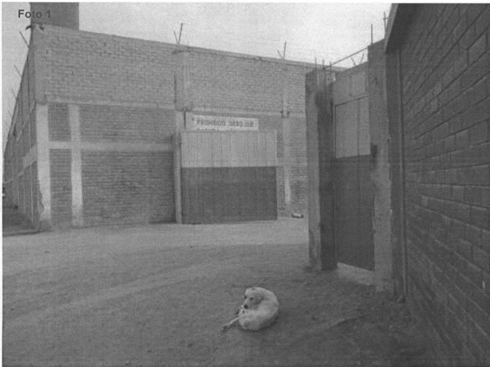
Fotografía N° 1. Vista frontal de la puerta de ingreso a las instalaciones donde opera la Municipalidad de San Juan de Lurigancho, en el parque 14A, en el punto georeferenciado N° 1, del Cuadro N° 1. Coordenadas UTM WGS 84 (18L 0281551E 8674993N)
