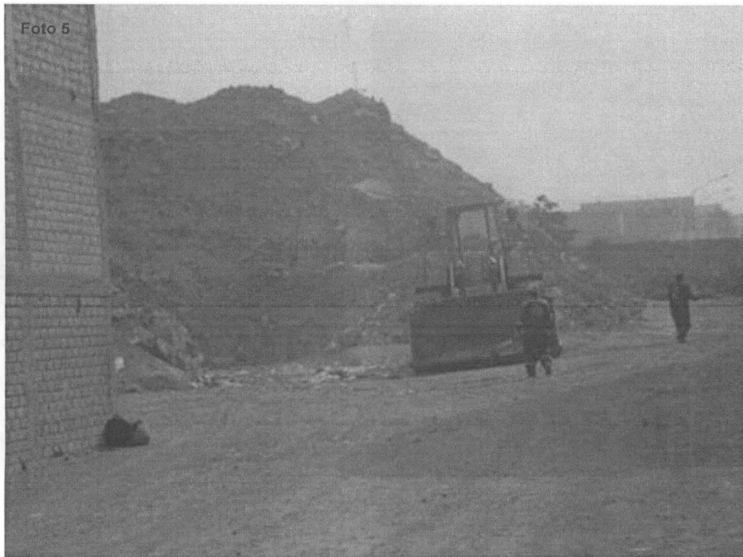
Fotografía N° 5. Evidencia de la existencia de un cargador frontal con el cual se remueven los residuos sólidos y se cargan a los camiones madrina, en el punto georeferenciado N° 2, del Cuadro N° 1. Coordenadas UTM WGS 84 (18L 0281575E 8675047N)
