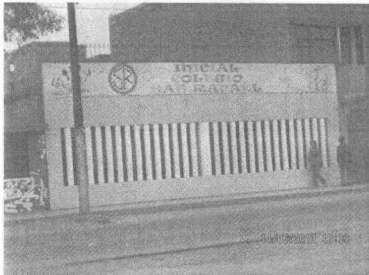
Fotografía N° 19, Centro Educativo de Nivel Inicial San Rafael en el cual estudian 200 niños en el nivel inicial.
