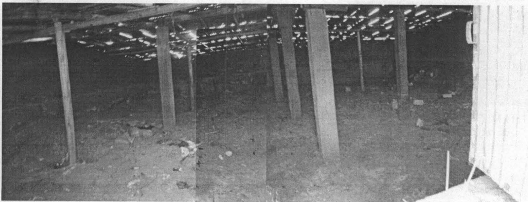
Foto 36: Interior de la infraestructura para residuos hospitalarios
