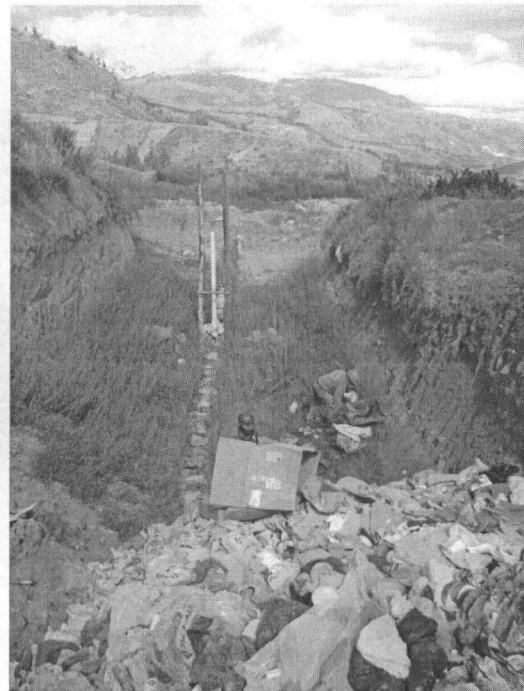
Foto 33: Celda de disposición de residuos con la chimenea para gases
