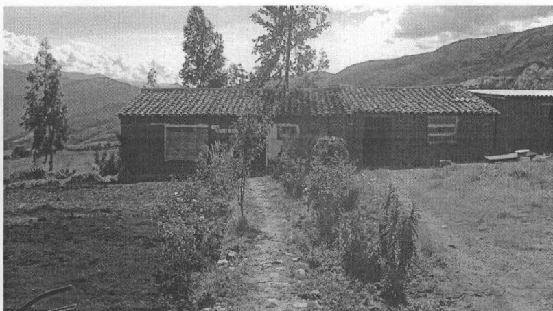
Foto 7: Instalaciones de administración y vigilancia del sitio de disposición de residuos de Carhuaz
