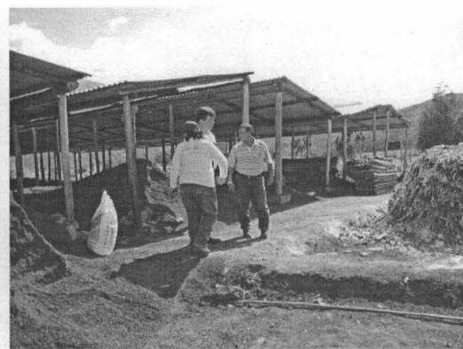
Foto 18: Vista de la planta de tratamiento de residuos orgánicos
