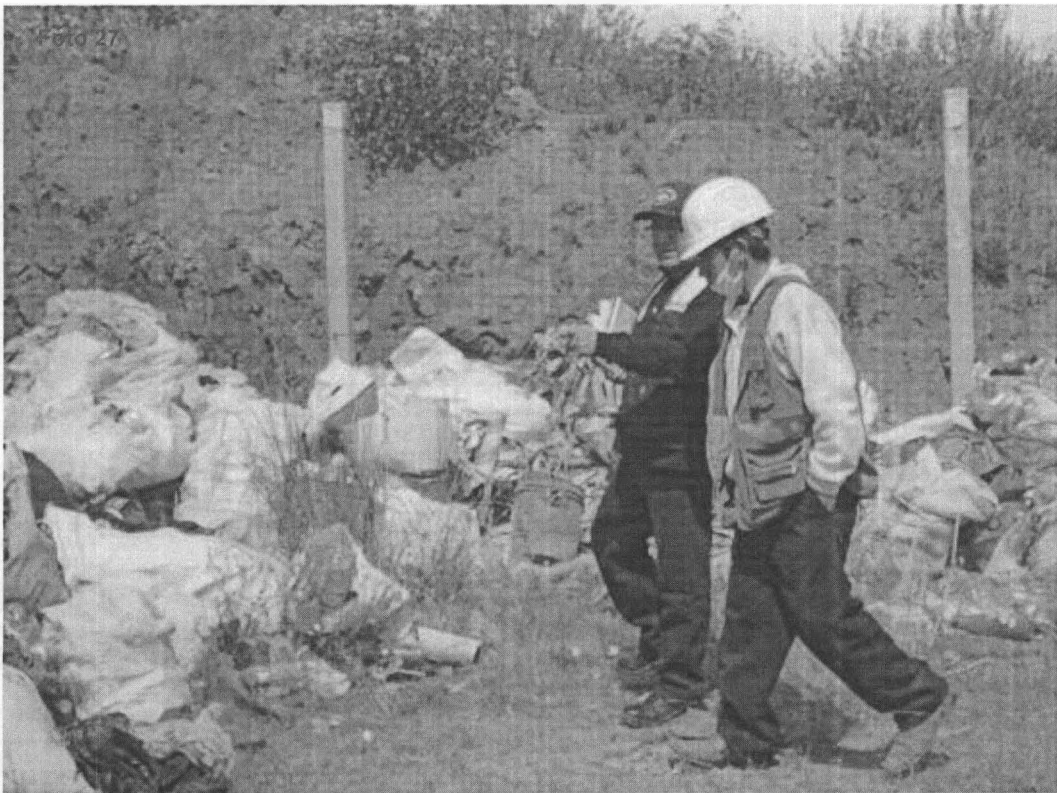
Fotografía N° 27. Evidencias de la disposición de los residuos clasificados, en el interior de la Planta de tratamiento de residuos sólidos, del Distrito de Huamantanga, en el punto georeferenciado N° 1, del Cuadro N° 6. Coordenadas UTM WGS 84 (18L 308518E 8728704N)
