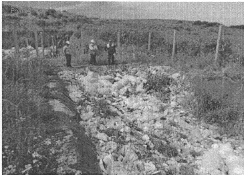
Fotografía N° 29. Evidencia del grado de cobertura por residuos sólidos, de la poza impermeabilizada de disposición final de residuos sólidos, en el punto georeferenciado N° 2, del Cuadro N° 6. Coordenadas UTM WGS 84 (18L 308485E 8728688N)
