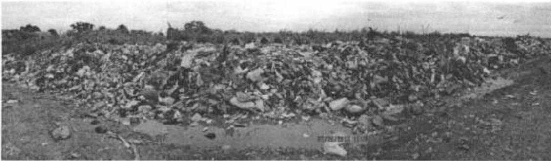
Foto 12: Residuos sólidos dispuestos en el lado izquierdo de la entrada, se aprecia la diversidad de los residuos, la presencia de gallinazos y de los líquidos percolados
