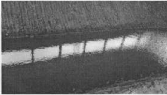
Foto 32: Balsa de lixiviados sin conexión con el relleno y con presencia de agua
