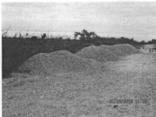
Foto 20: Material para el afirmado de las carreteras (grava)
