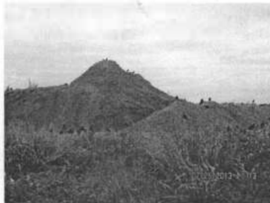
Foto 21: Material de excavación del relleno
