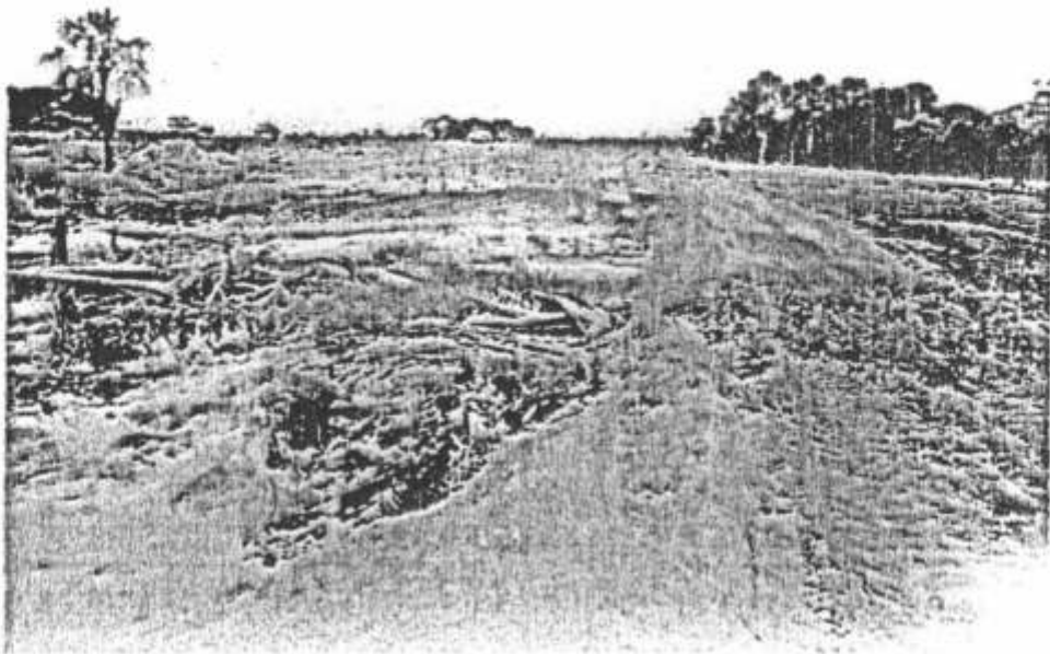
VISTA DE AREA DE PLATAFORMA INICIAL DE OBRA.
