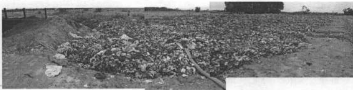
Foto 34: Acumulación de residuos en el lado de mayor longitud del relleno
