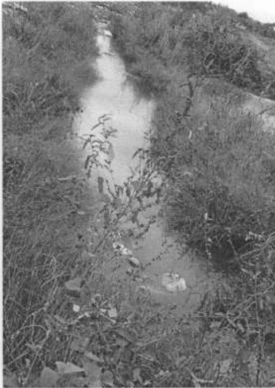
Foto 24: Canal de escorrentía sin desagüe, con lixiviados y agua de lluvias
