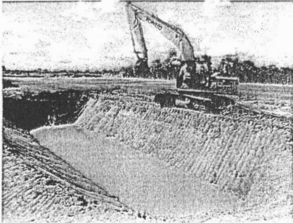
CULMINACION DE TALUD DE POZO LIXIVIADOS
