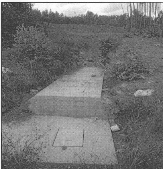
Fotografía N° 12 Tanques colectores de lixiviados ubicados en la parte inferior de las celdas.
