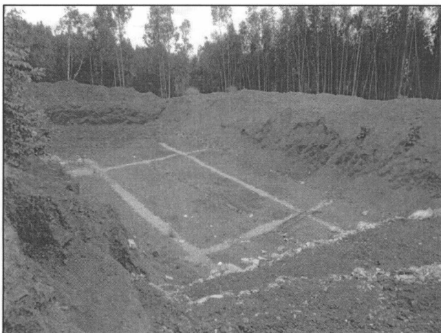
Fotografía N° 9 Trinchera ubicada en la parte inferior del botadero, donde se puede apreciar los drenes de lixiviación.
