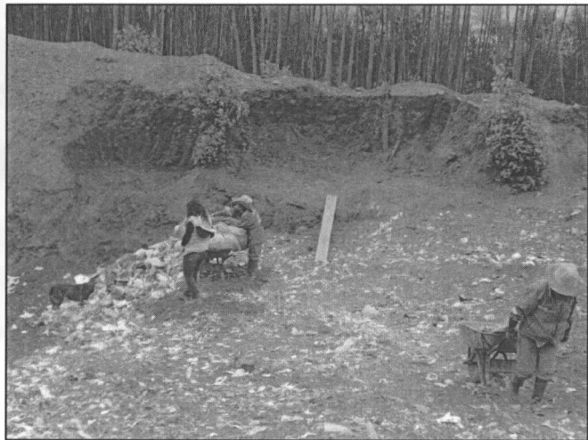
Fotografía N° 8 Transporte de residuos sólidos por medio de carretillas hacia su disposición final en la celda de la parte baja.
