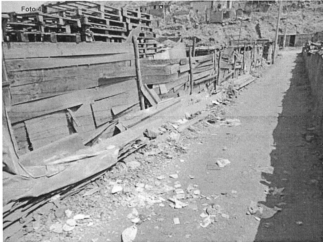
Fotografía N° 4. Evidencia del tipo de infraestructura existente en las Chancherías de Nueva Esperanza, en el punto georeferenciado N° 3, del Cuadro N° 1. Coordenadas UTM WGS 84 (18L 0291149E 8655878N)
