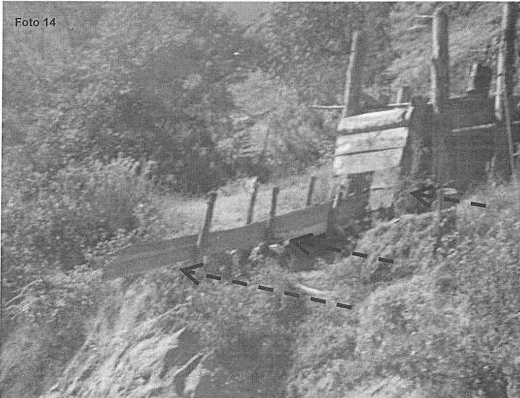
Fotografía N° 14. Evidencia de instalaciones artesanales de tolvas en las partes altas de la vía de acceso, para la carga de mineral triturado a los volquetes de la mina Vale un Perú, en el punto georeferenciado N° 4, del Cuadro N° 1. Coordenadas UTM WGS 84 (17L 0828415E 9004971N)
