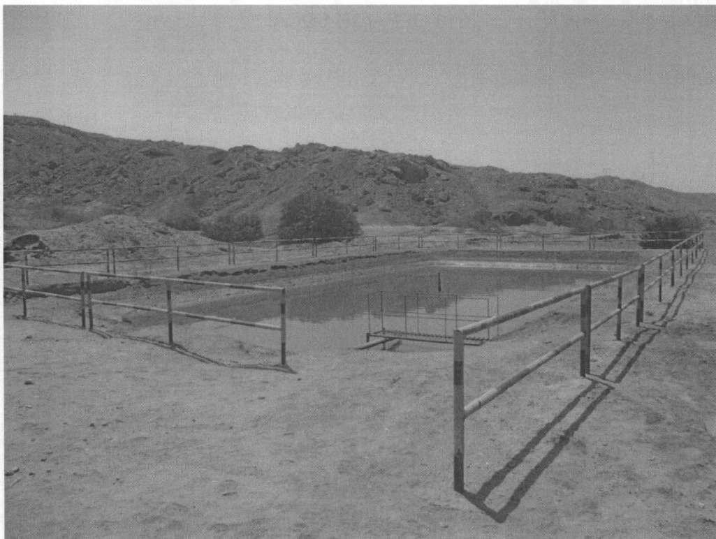
FOTOGRAFÍA N° 1: Poza de evaporación
