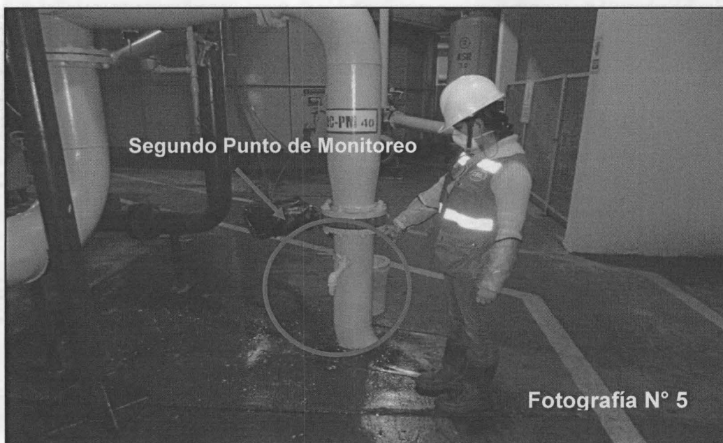
Fotografía N° 5. Se observa el segundo punto de monitoreo, a la salida de los efluentes de la última etapa de tratamiento físico-químico.
