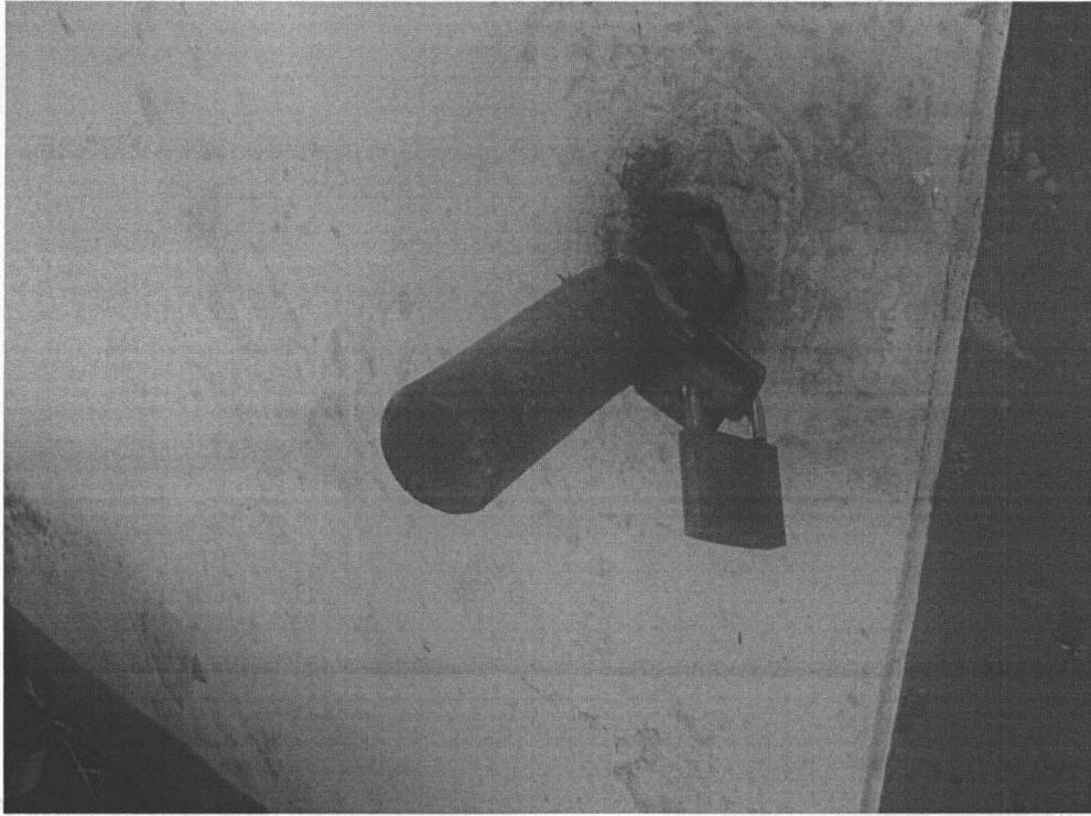
Tubería de carga descarga de combustible sellado con cinta teflón.
