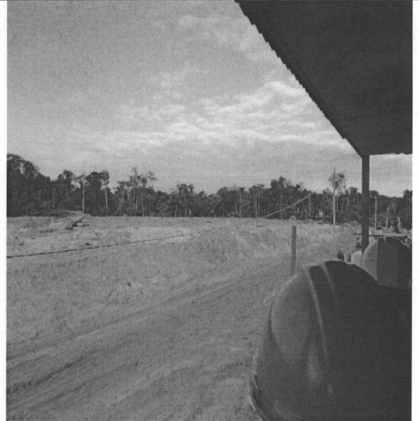
Vista 2 Labores de disposición de residuos.
