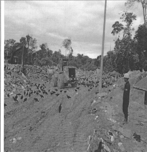
Vista 1 Plataforma del Relleno Celda N° 1.
