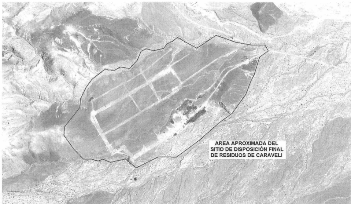
Ilustración 4: Perímetro aproximado del sitio de disposición final, observándose los cauces de las riadas en épocas de lluvia
