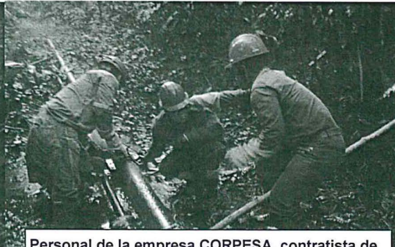
Personal de la empresa CORPESA, contratista de Pluspetrol, colocando una grapa para detener el derrame
