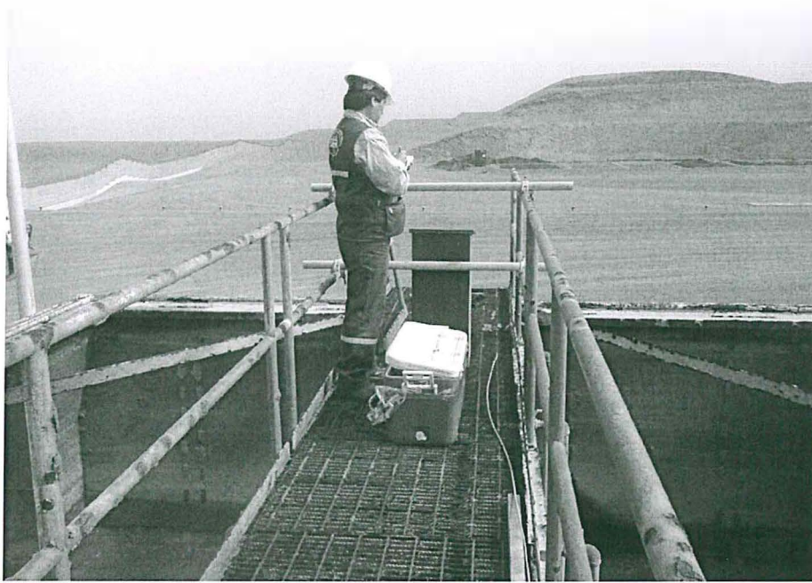
Fotografía N° 1. Afluente de la planta de efluentes líquidos de la empresa Perú LNG
