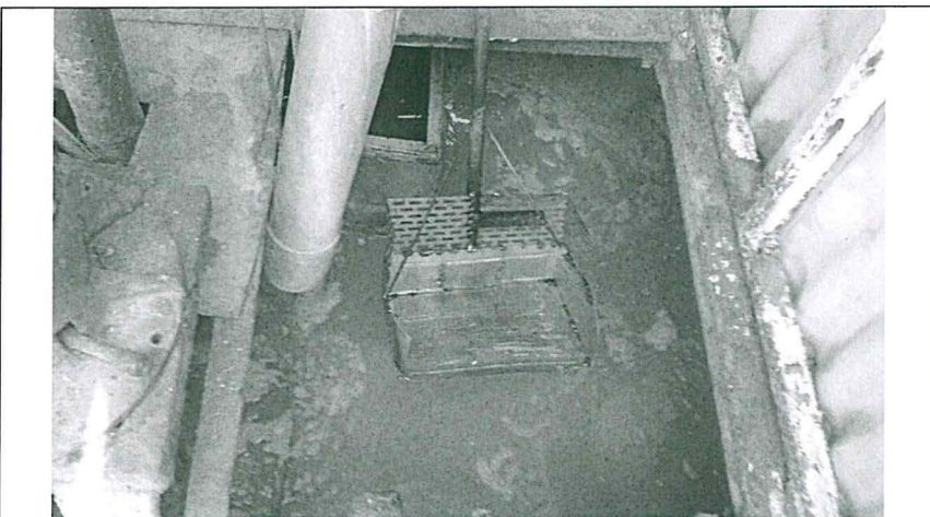
Figura 03. Planta PANAFOODS. Punto CRS2 extracción de material grueso mediante una pala. 19 de Ago.2013
