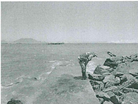
Foto 5: (BF-V8) vertido empresa Inversiones Generales del Sur SA, altura Jr. Ancash.
