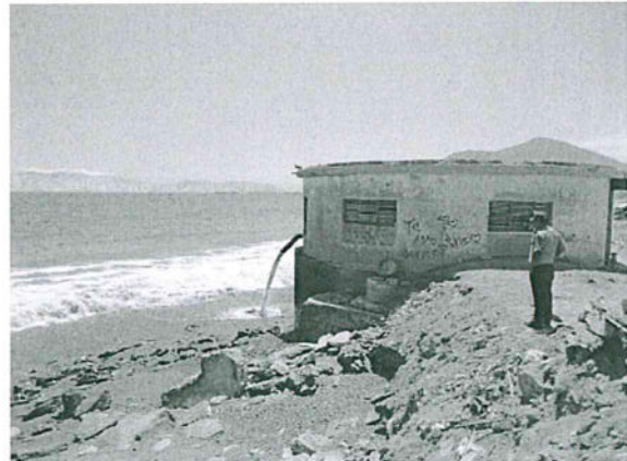
Foto 4: (BF-V5) Cámara de rebombeo "Ica", altura calle 28 de Julio
