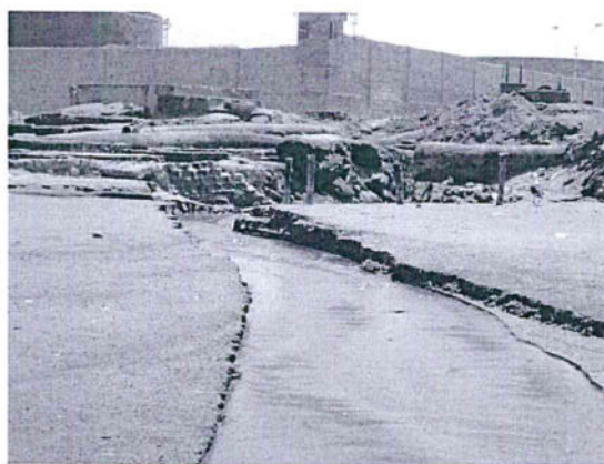
Foto 8: (BF-V1) vertido recuperación artesanal de aceite, Zona 27 de Noviembre.
