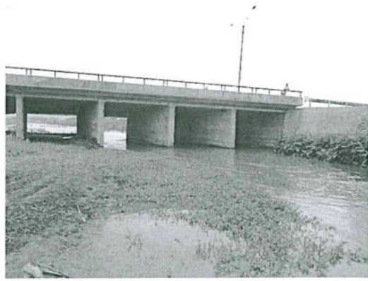
Foto 14: (RL-1) altura del puente Lacramarca.
