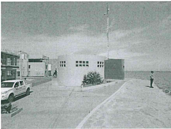
Foto 3: Cámara de rebombeo "Palacios" y Jr. Enrique Palacios, cercana a estación BF-AM5
