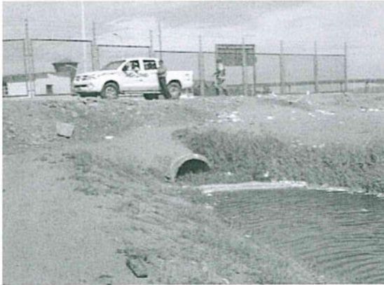
Foto 1: (BF-V9) Vertimiento de Sider Perú (no llega a mezclarse con agua de mar)
