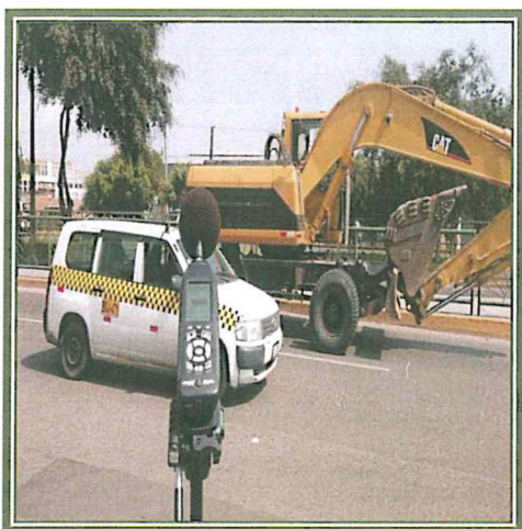
FOTO N° 71: ESTACIÓN DE MONITOREO 1353,RUI-03
