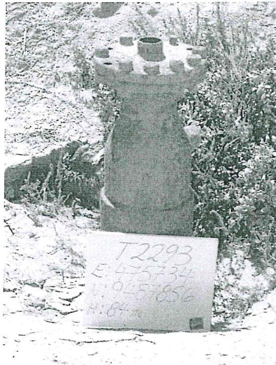
Fotografía N° 1. Pozo inactivo mal abandonado con código UWI T2293, se observa casing con brida corroído de 0,85 m de alto.
