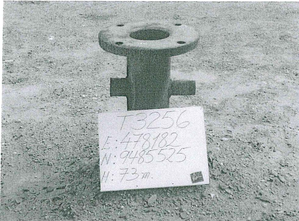
Fotografía N° 1. Pozo abandonado T3256, no sellado y con presencia de óxido en su estructura.
