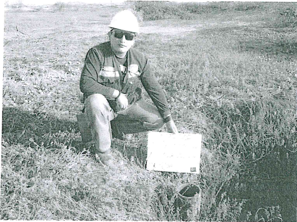
Fotografía N° 1. Pozo mal abandonado con código UWI T2378, sin cabezal, con casing corroído y no sellado, cubierto por la vegetación.
