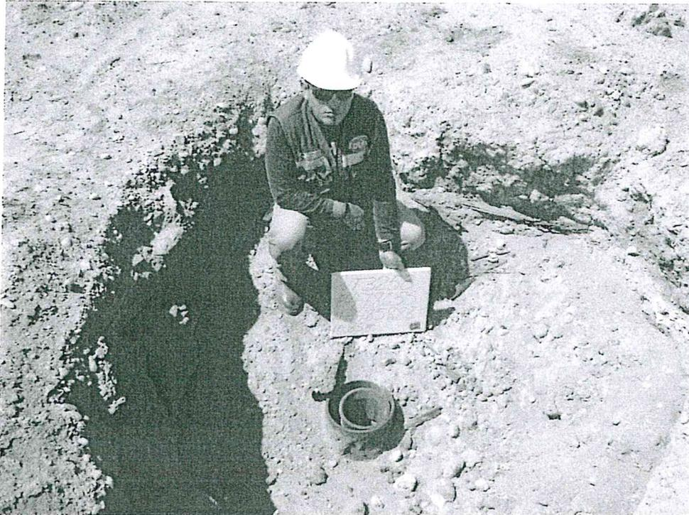
Fotografía N° 1. Pozo mal abandonado con código UWI T3258, sin cabezal y no sellado herméticamente.
