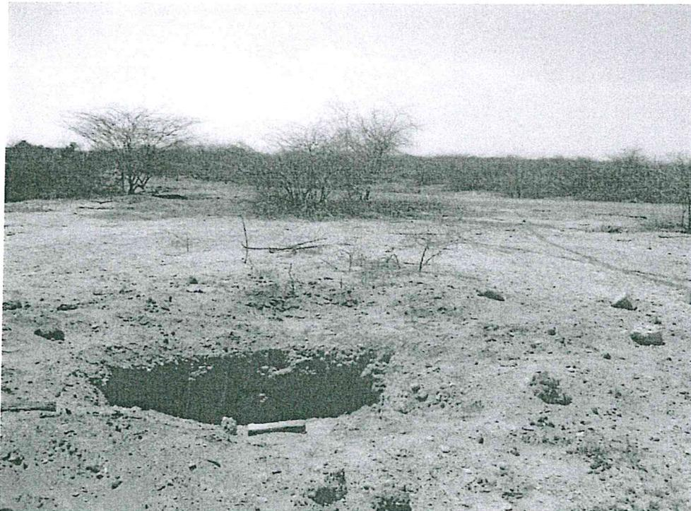
Fotografía N° 2. Vista panorámica de la ubicación del pozo mal abandonado. El pozo se encuentra dentro de un hoyo de 0,79 m de profundidad, no se visualiza señales ni delimitación de la zona.
