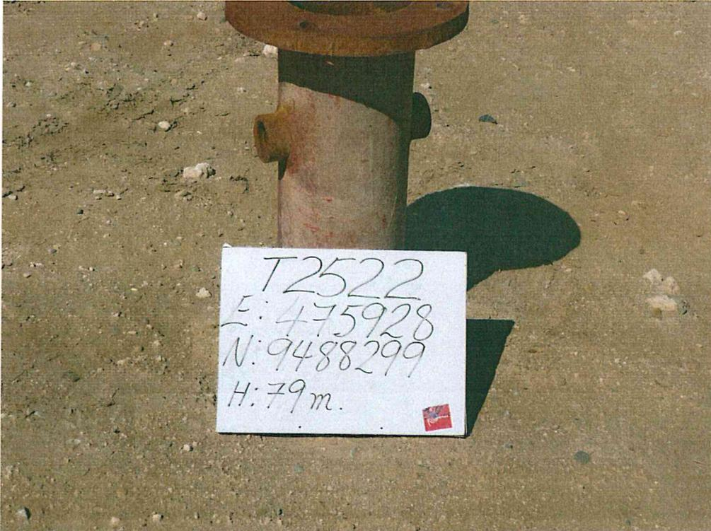
Fotografía N° 1. Pozo mal abandonado no sellado herméticamente, presenta casing y brida corroídos.
