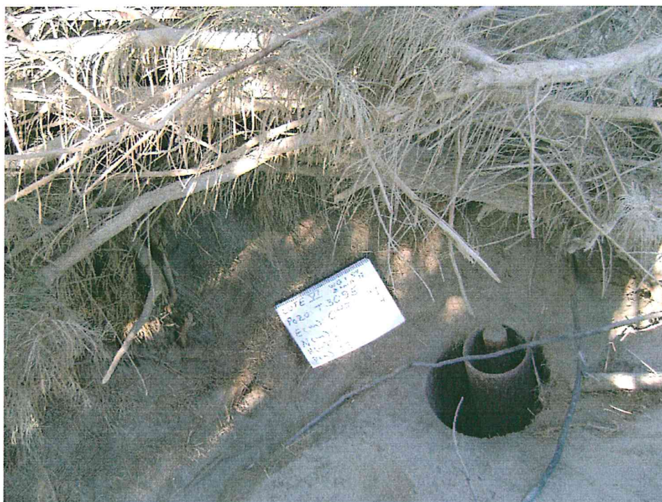
Fotografía N° 1. Se observa el descubierto del pozo mal abandonado, con tres diámetros diferentes de casing, sin tapón y al aire libre.
